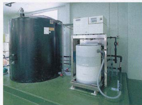
■クロール水供給装置
